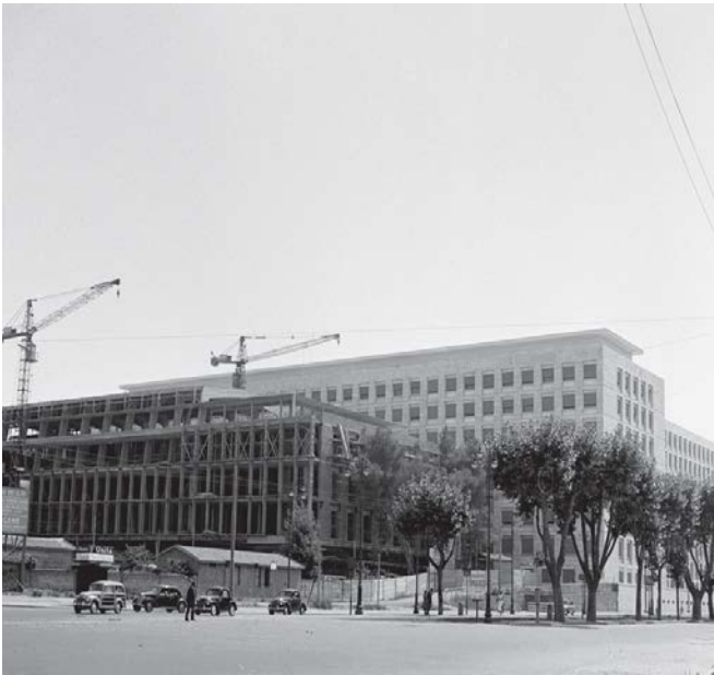
1951: Lavori in corso negli edifici che ospiteranno la FAO a Roma
