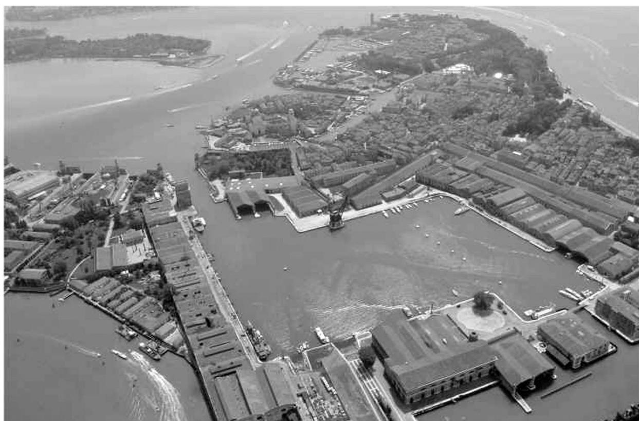
Fig. 40 – Veduta aerea dell’Arsenale verso la bocca di porto
