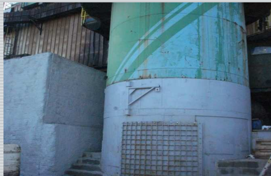
Torre granulazione loppa
