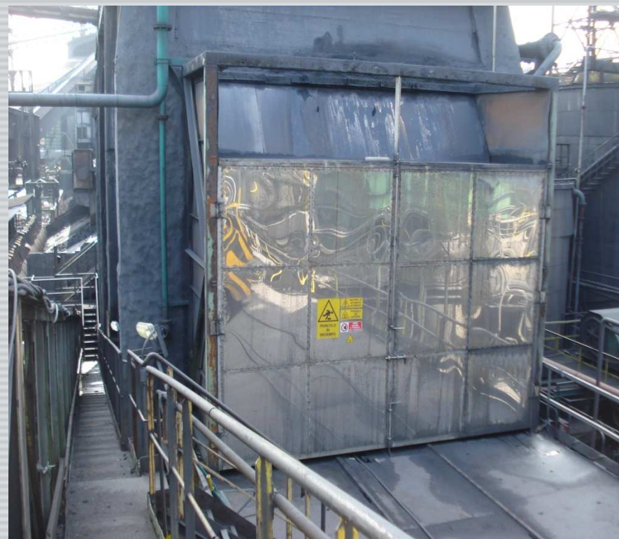
Chiusura torre spegnimento
