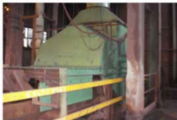
CAPPA SUL ROMPIZOLLE
