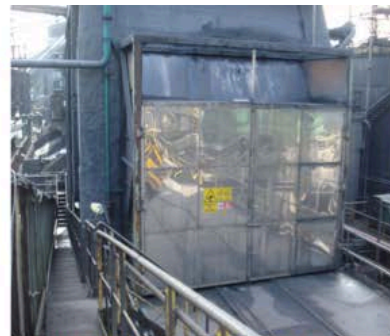
CHIUSURA TORRE DI SPEGNIMENTO
