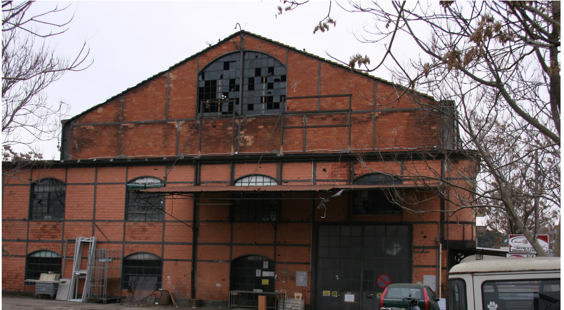
generatore elettrico linea tranviaria, anni '50 - Firenze
