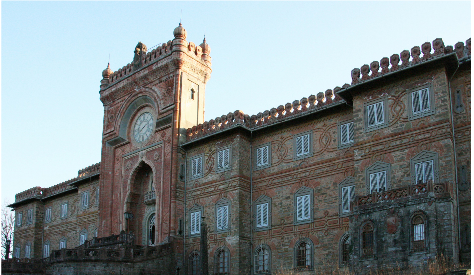
Castello di Sammezzano, 1605 - loc. Il Leccio (FI)
