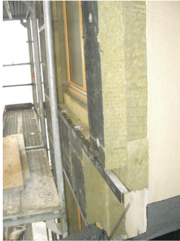
Figura 2: isolamento a cappotto in una ristrutturazione profonda
