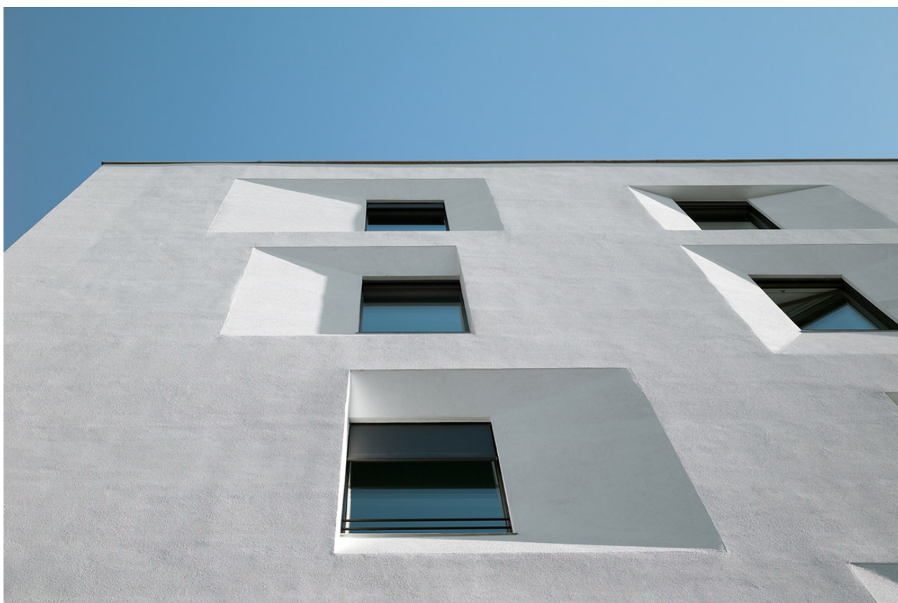
Figura 1: ristrutturazione profonda dell'edificio ex-posta di Bolzano, Arch. M.Tribus
