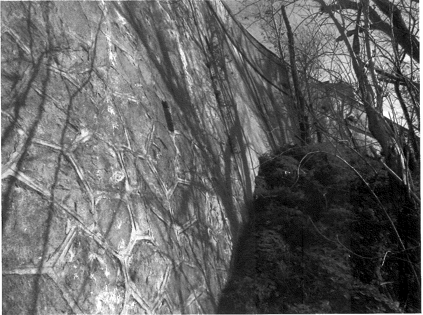
Figura 13 - Vista generale del muro di sostegno versante meridionale.
