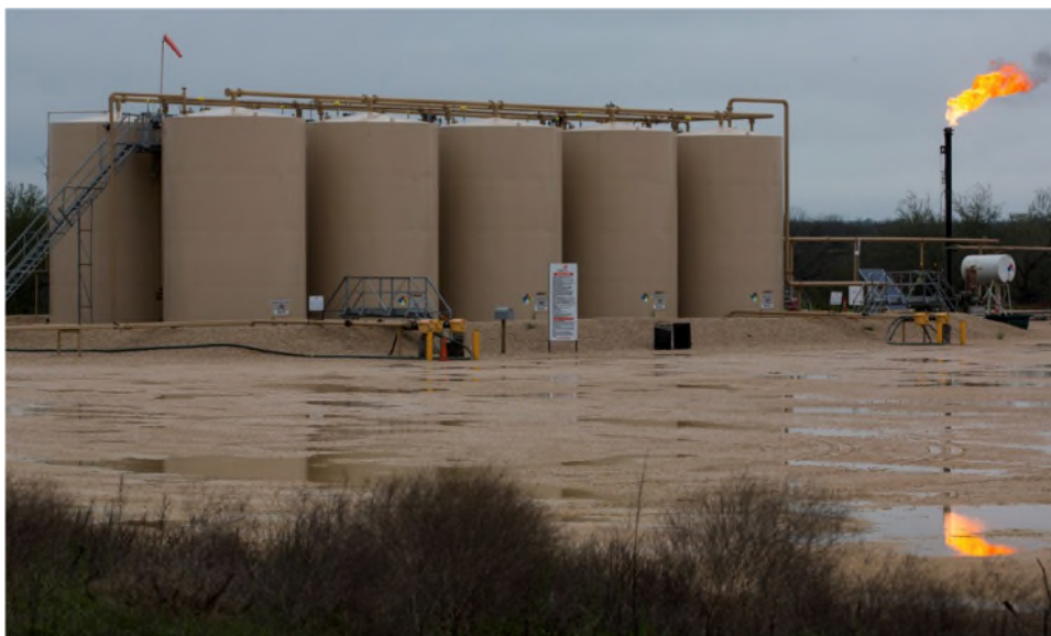
Fig. 3 - Il gas che esce dai pozzi di petrolio, dalle raffinerie e dagli impianti chimici è spesso considerato un rifiuto che viene bruciato senza produzione di energia (gas flaring)
