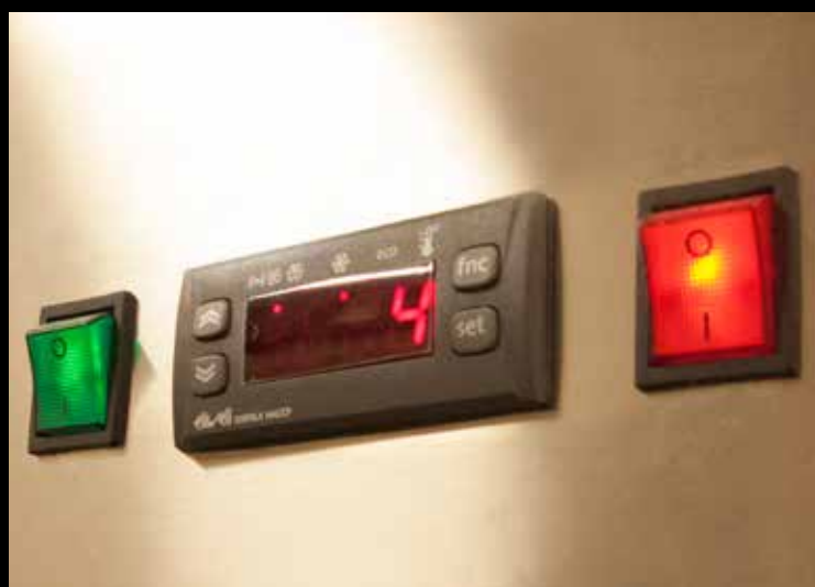
30. Cella di conservazione delle carni
