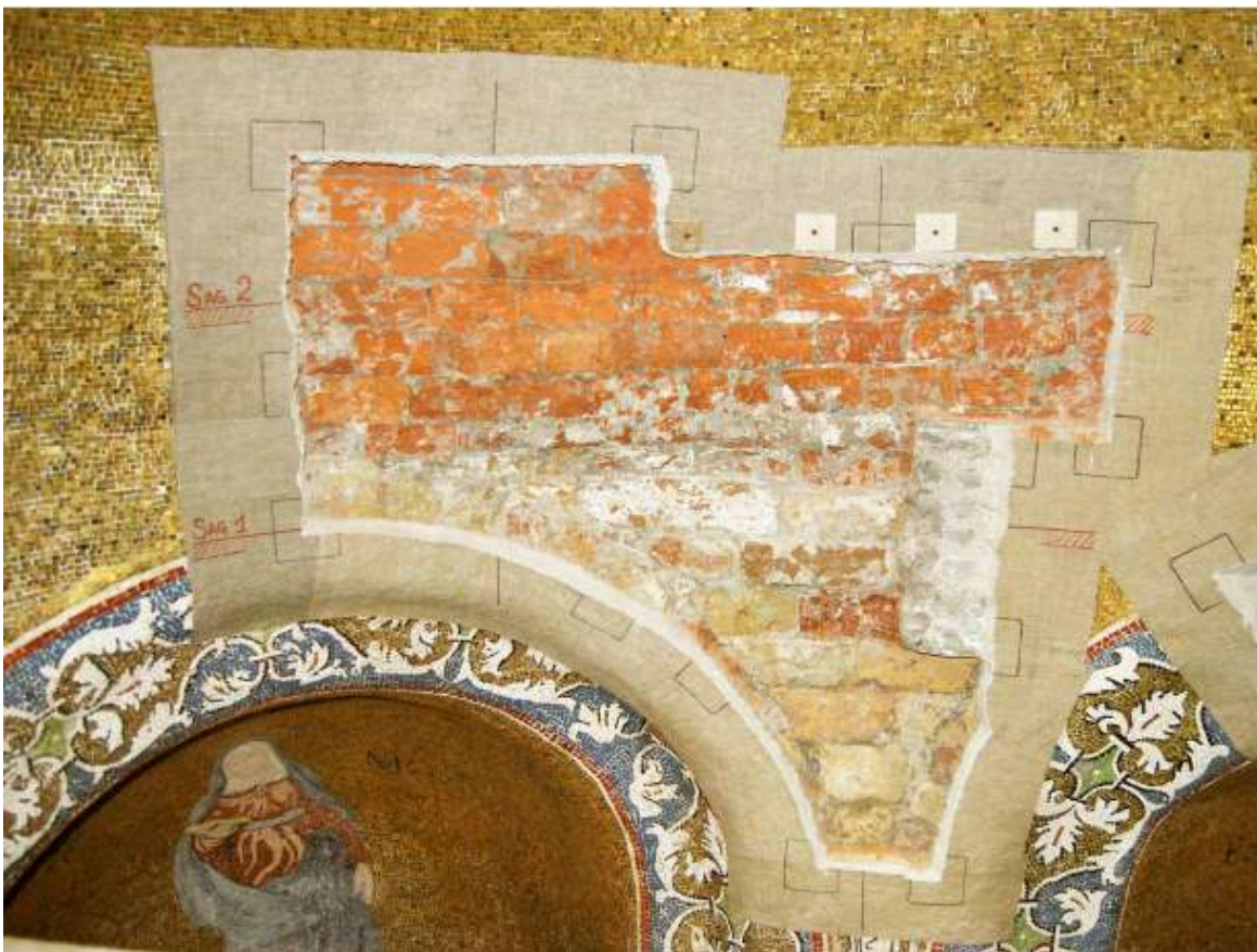
Figura 2 – I mosaici interni della tomba, in parte distaccati una ventina d'anni fa.
