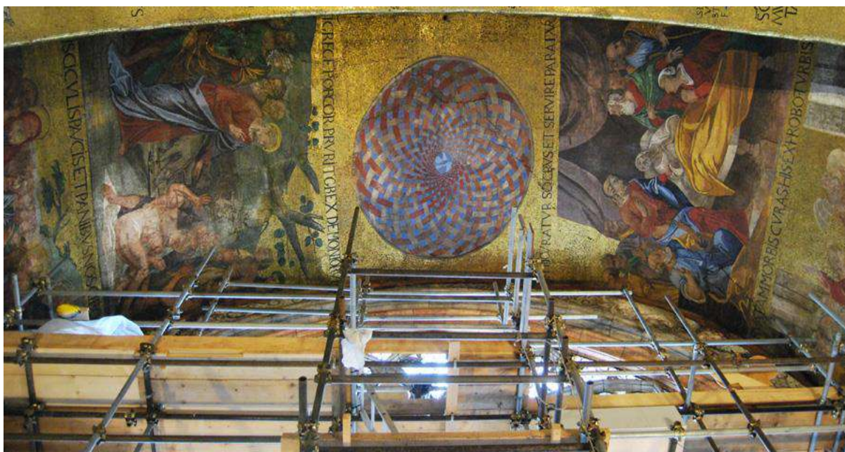
Figura 2 – La volta mosaicata e i ponteggi montati per l'ispezione ravvicinata delle condizioni del mosaico.
