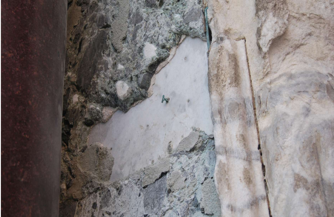
Figura 10 – Prospetto ovest. Cadute del rivestimento marmoreo di Verde Antico e degrado dello stipite di uno dei portali.
