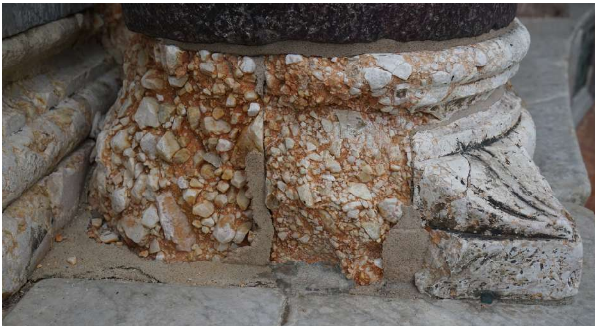
Figura 5 – Il degrado subito da una base di Pommarolo (Isola di Arbe, Croazia)
