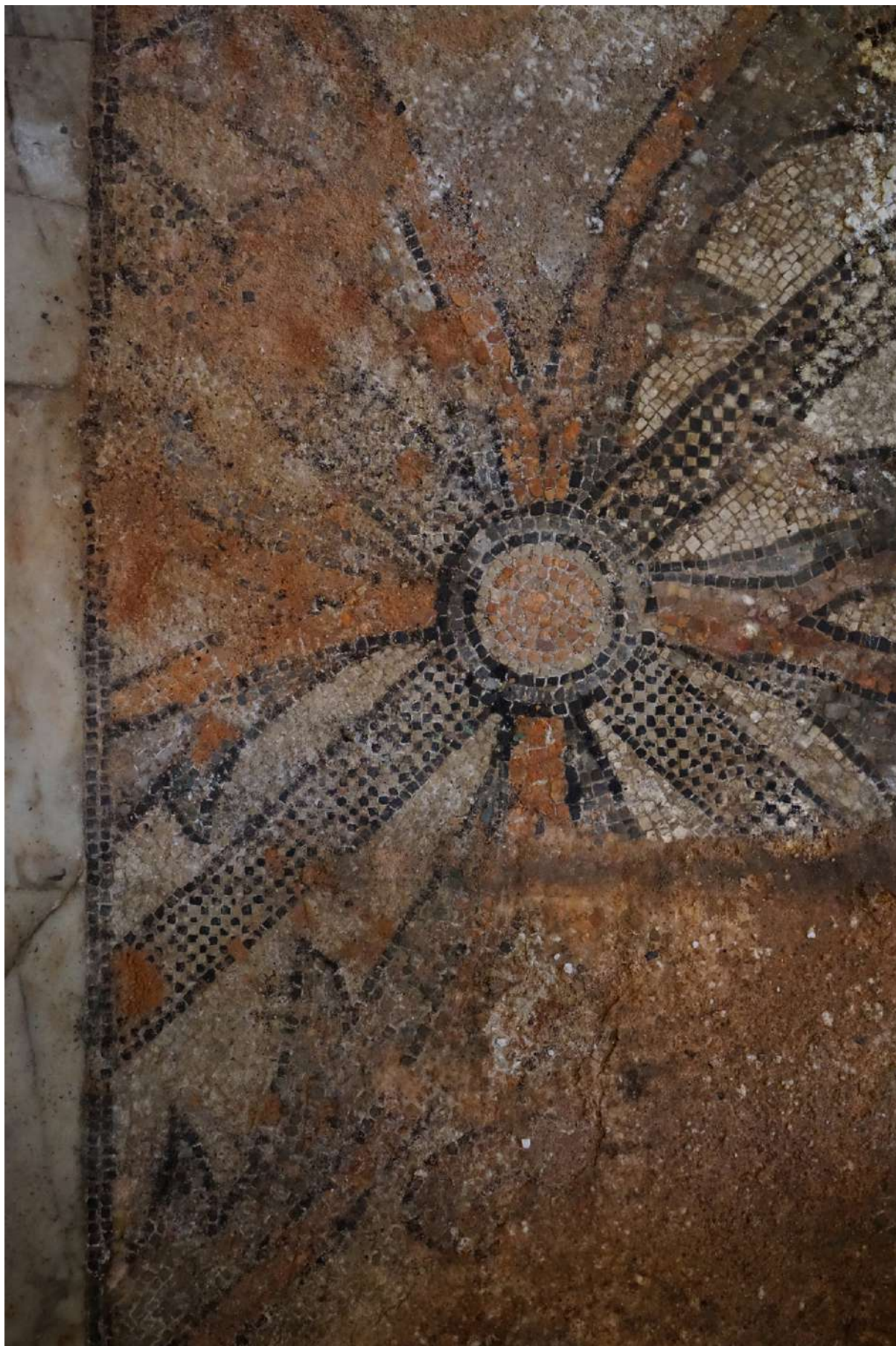
Figura 3 – Il gravissimo stato conservativo di un tratto di superficie pavimentale.
