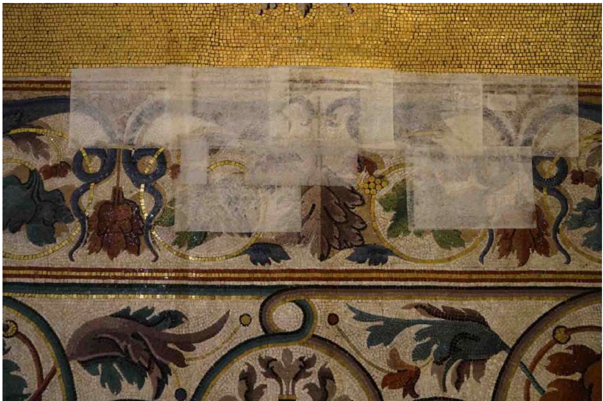
Figura 5 – Una velatura di protezione applicata su un tratto musivo decorato a fogliami, per impedire la caduta di tessere e di intere parti decorate.
