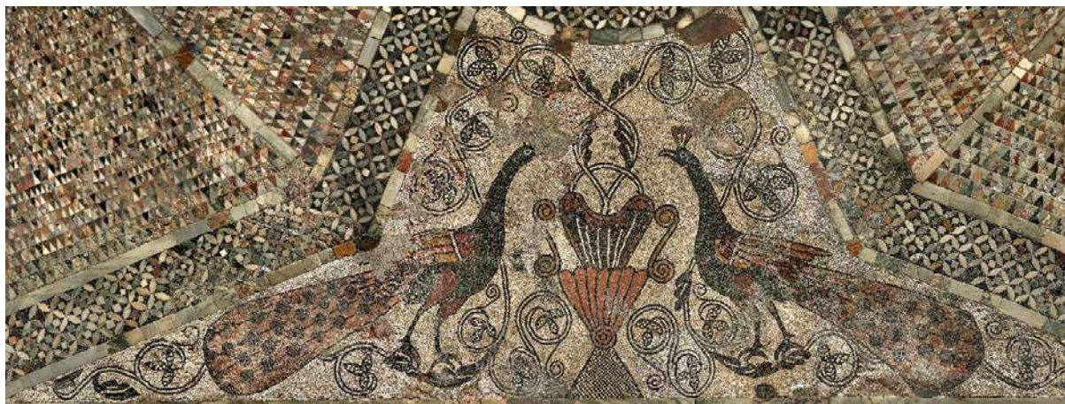
Figura 1 – Fotoaddrizzamento in scala su rilievo laser-scanner Il tratto di pavimentazione con la coppia di pavoni, nello stato precedente ai danni provocati dall'acqua alta del novembre 2019.
