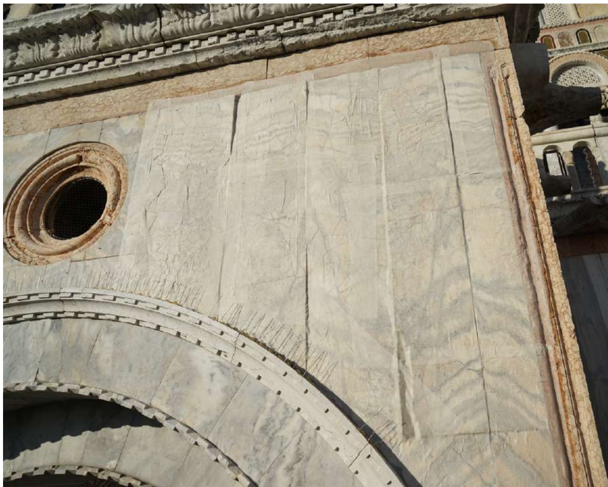
Figura 2 – Il dissesto e i distacchi delle lastre marmoree di Proconnesio, messe in evidenza dalla luce radente. Si nota la presenza dello strato di preconsolidamento e protezione in carta e resina.
