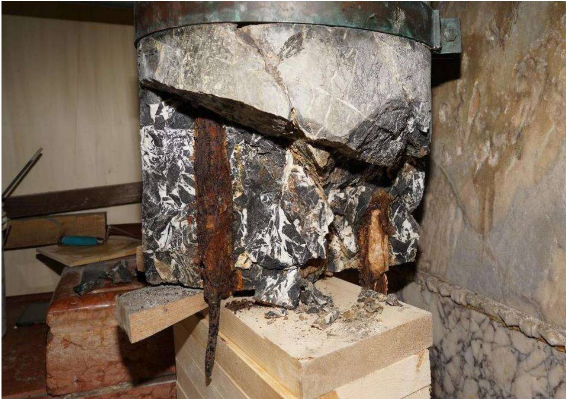
Figura 21 – Nartece. Le fratture del fusto provocate dall'ossidazione dei perni metallici
