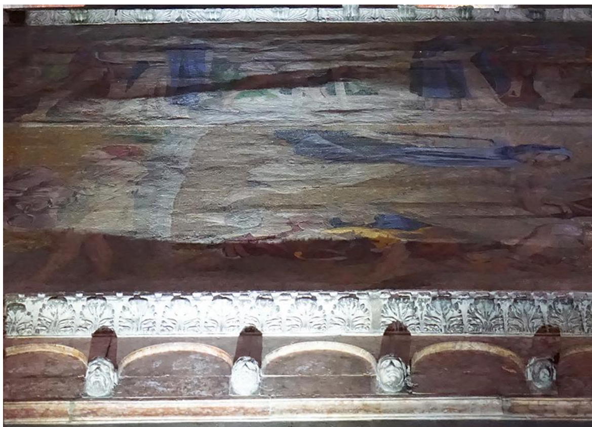
Figura 8 – I gravi distacchi delle superfici mosaicate, messe in evidenza dalla luce radente.
