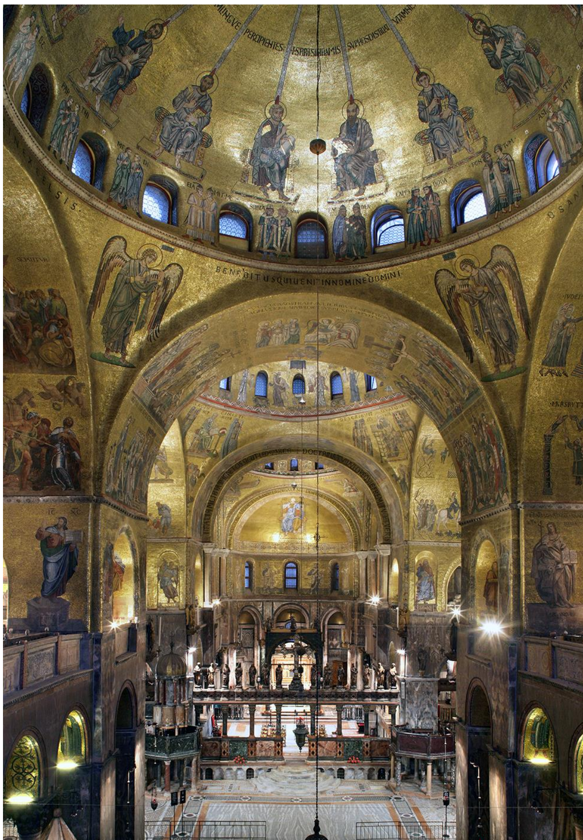
Figura 39 – L'attuale impianto di illuminazione, da rinnovare con luci LED.
