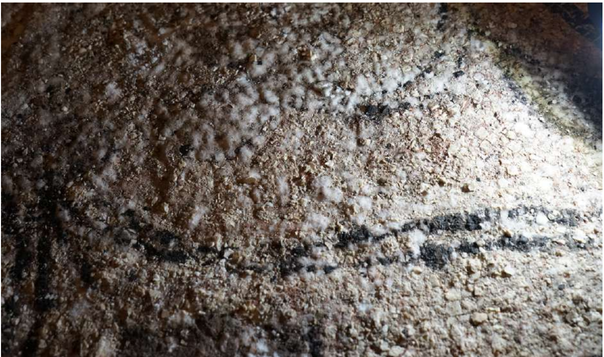
Figura 3 – Formazioni saline su un tratto della pavimentazione.
