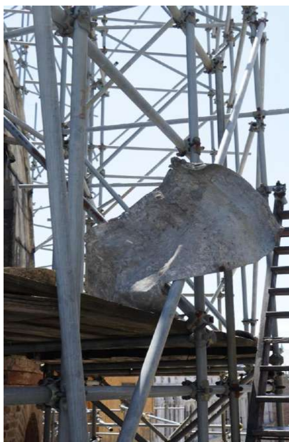
Figura 7 – Le lastre del manto plumbeo strappate dal vento il 12 novembre 2019.
