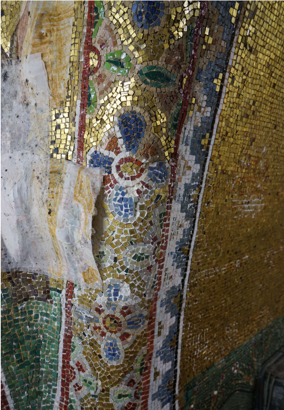
Figura 18 – Nartece. Il distacco, bloccato con un intervento di protezione realizzato con carta giapponese, di un tratto di mosaico della volta.
