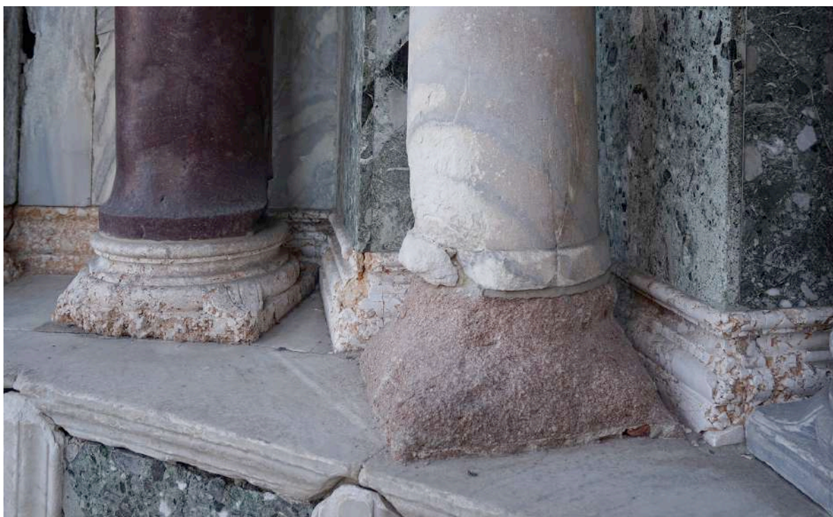
Figura 4 – Il pesante degrado subito da una base di Semesanto (isola di Arbe, Croazia) di una colonna.
