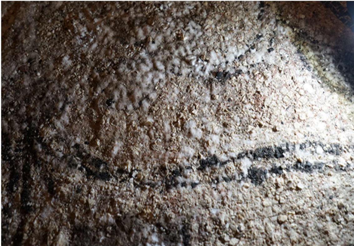
Figura 14 – Le formazioni cristalline di cloruro sodico su un tratto della pavimentazione musiva dell'altare del Santissimo.
