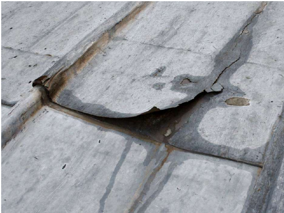
Figura 5 – Una lastra parzialmente sollevata e fratturata dall'azione del vento.
