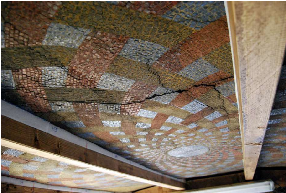
Figura 3 – Una frattura che corre nel tratto centrale del mosaico.
