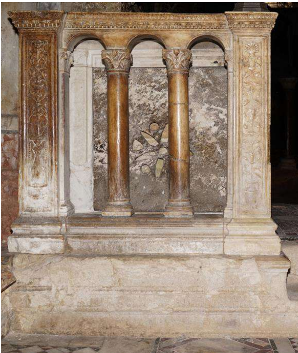
Figura 4 – Le condizioni conservative dei gradini e delle ‘alette’ laterali.
