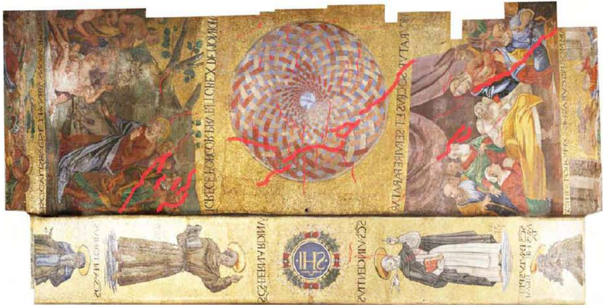
Figura 7 – Le lesioni presenti sulle superfici intradossali a mosaico della volta e dell’arcone contiguo, rilevate con laser-scanner e riportate su fotoraddrizzamento in scala.
