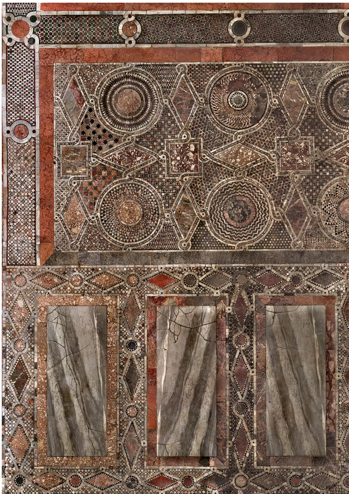
Figura 32 – Raddrizzamento fotografico (originale in scala 1:1) del pavimento tessulare della navata centrale di San Marco.
