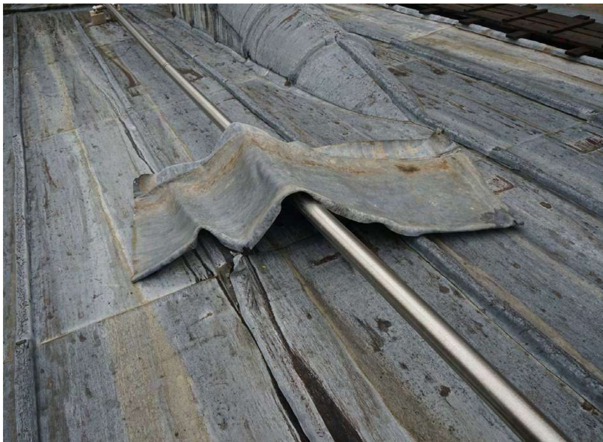
Figura 3 – Una lastra strappata e trasportata altrove dal vento.
