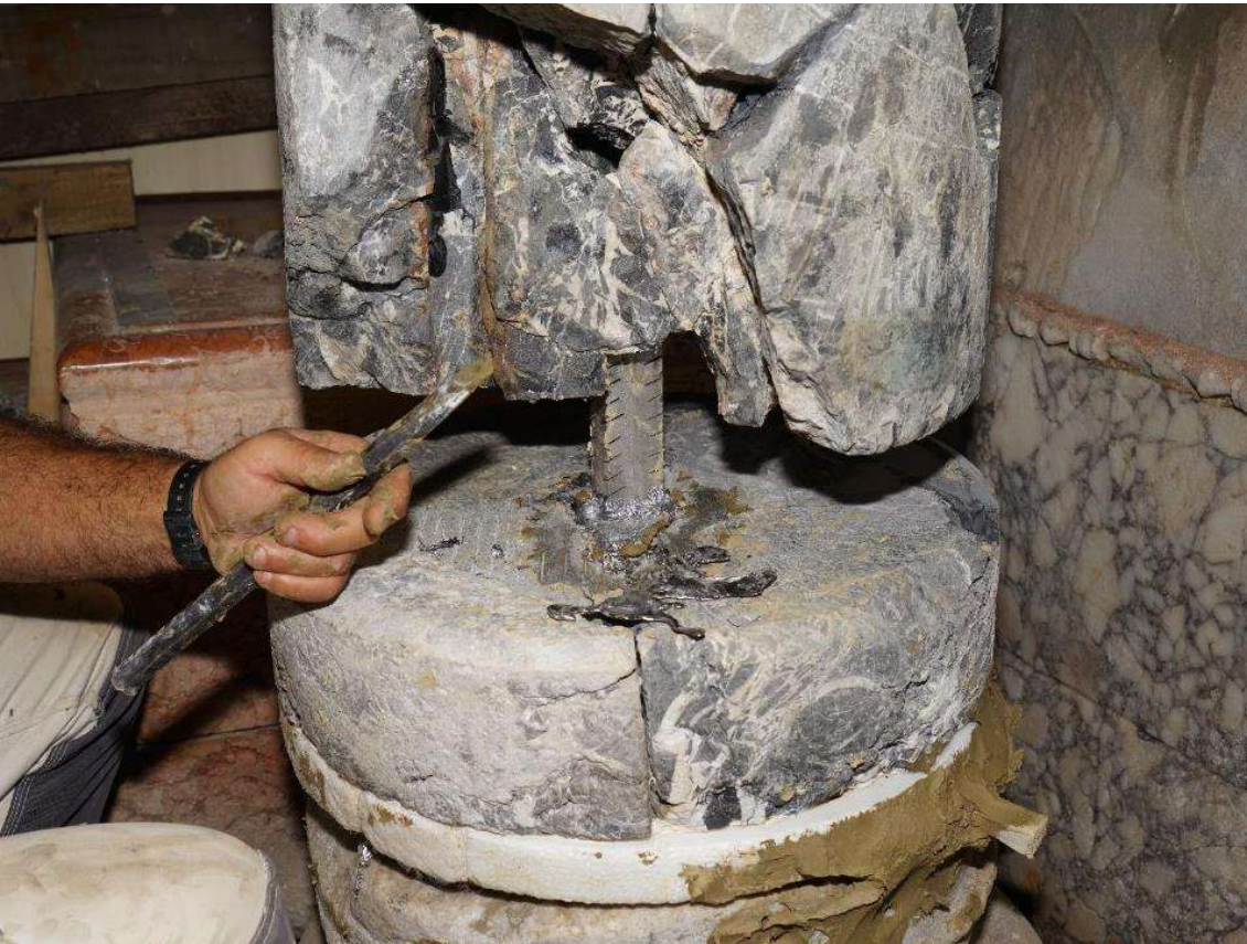
Figura 24 – Nartece. Ulteriore fase di consolidamento di una delle quattro colonne.
