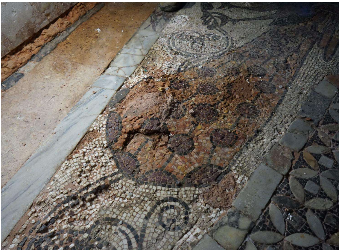
Figura 17 – Basilica, interno. Dettaglio di un tratto danneggiato della decorazione musiva con coppia di pavoni.
