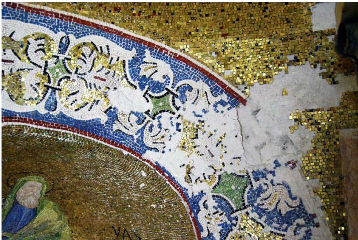
Figura 3 – Danni sofferti dai mosaici
