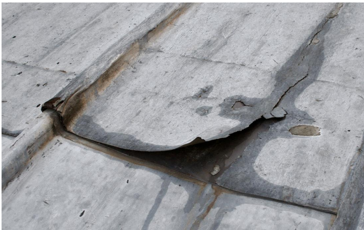
Figura 43 – Una lastra parzialmente sollevata e fratturata dall'azione del vento.
