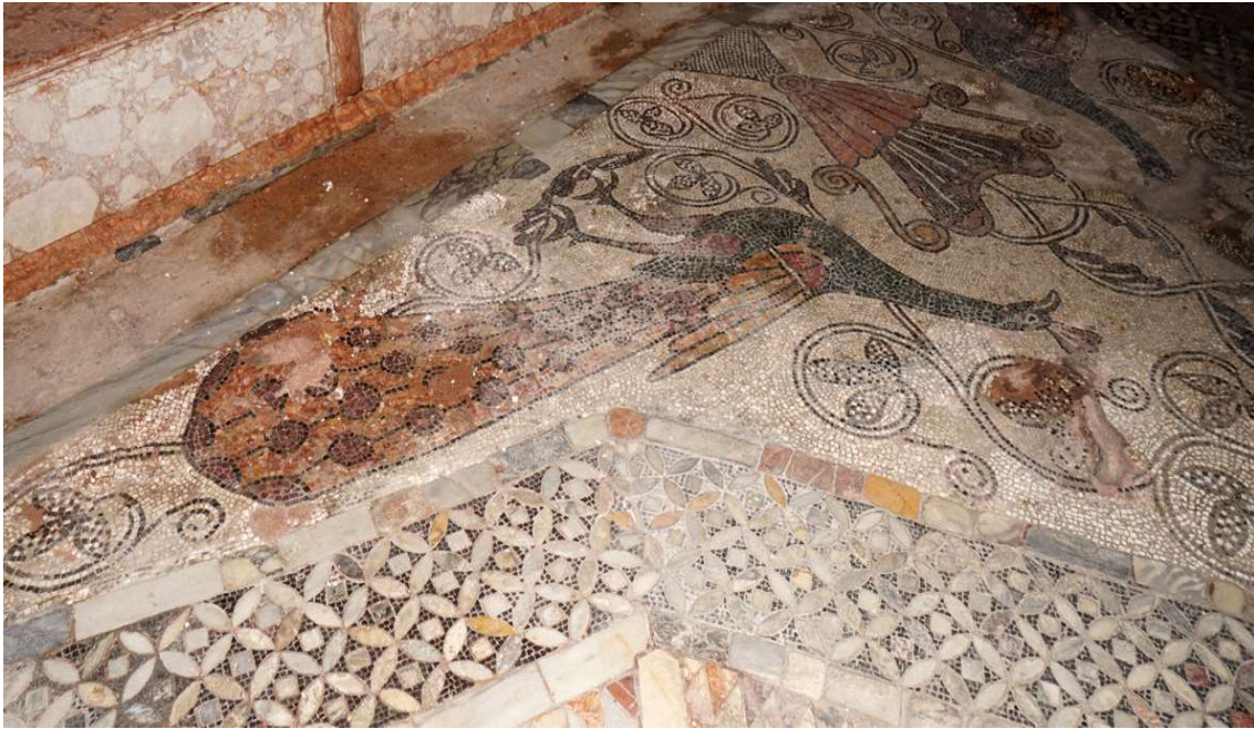
Figura 16 – Basilica, interno. I danni provocati dall' acqua alta a un tratto della pavimentazione musiva medievale con coppia di pavoni.
