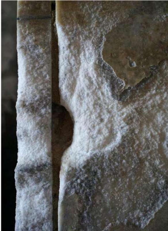
Figura 5 – Lo spessore minimo, di 3 cm, di una lastra degradata di marmo Proconnesio.
