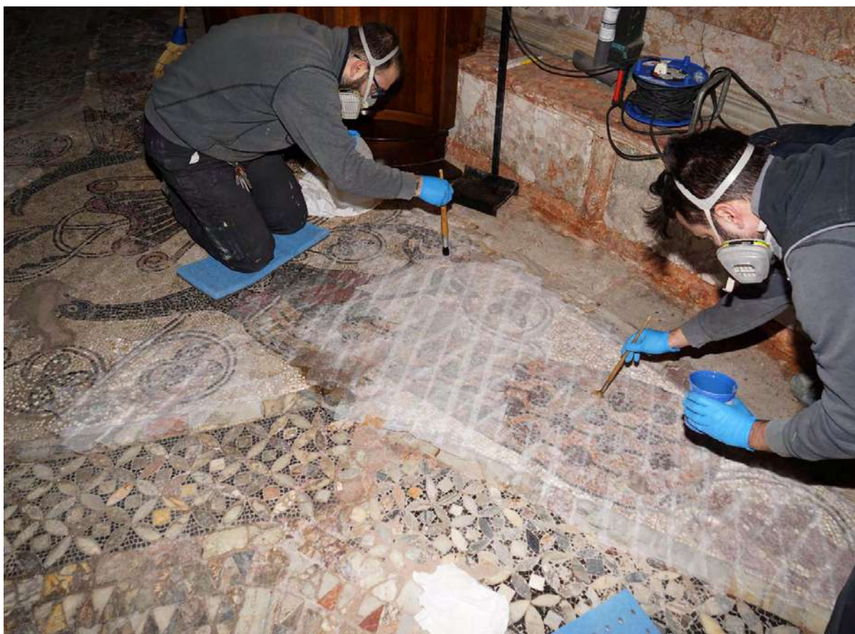
Figura 4 – L'applicazione di garze e resina acrilica sulle superfici già protette da un primo strato di carta.
