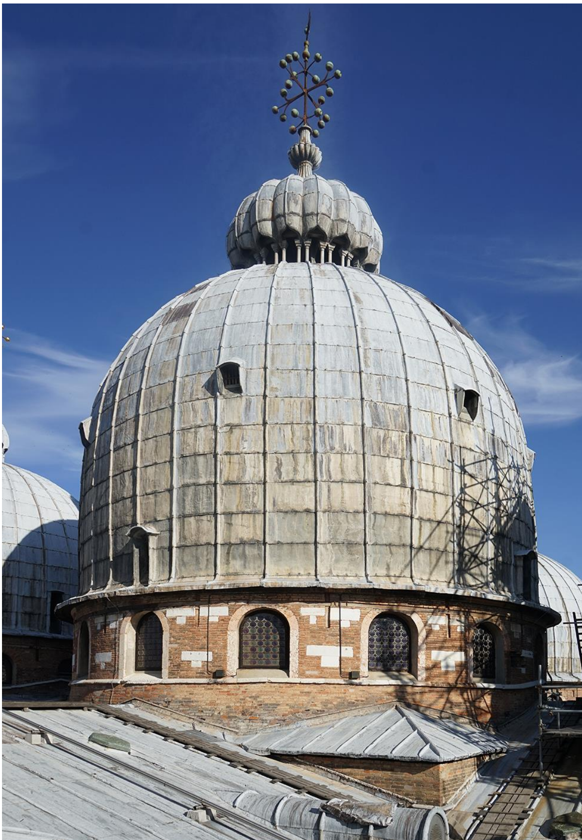
Figura 40 – La cupola dell'Ascensione, collocata al centro della Basilica
