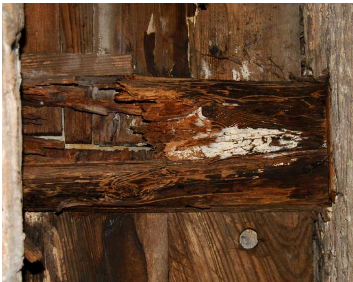
Figura 7 – La grave marcescenza di una trave lignea sottostante il tavolato.
