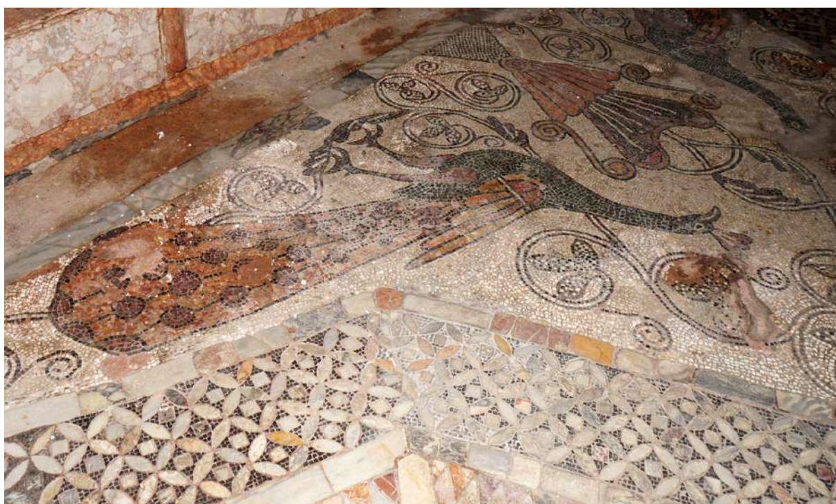
Figura 2 – Lo stato di degrado dopo l'acqua alta.
