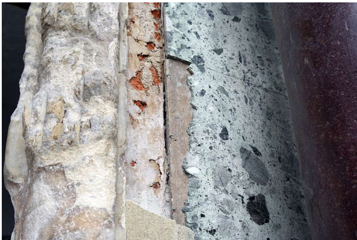
Figura 8 – Perdite di rivestimenti di Marmo Proconnesio e di Verde Antico.
