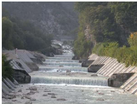
Briglie, argini, difese spondali, canalizzazione alvei...
