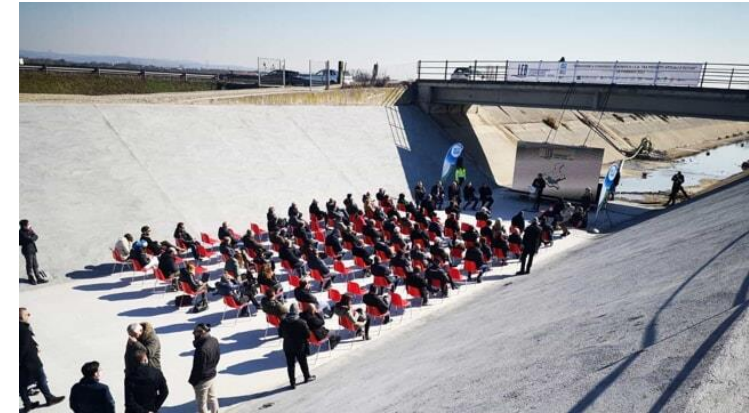
Visita al cantiere sul canale LEB (febbraio 2022)
