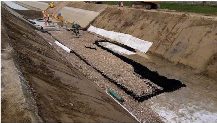
Lavori di sistemazione del canale LEB
